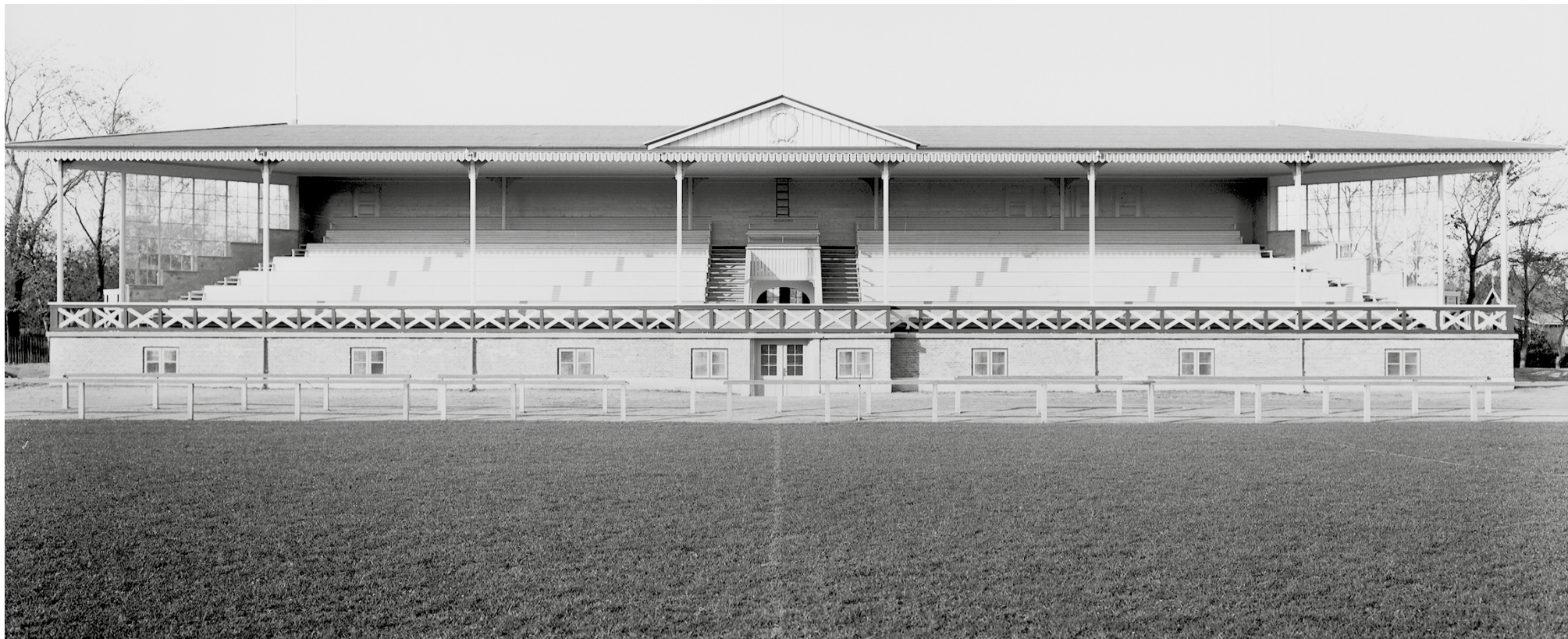
Aalborg Stadions første siddetribune fra 1927 ses her umiddelbart efter opførelsen. Under tribunen var der omklædningsrum, møderum og andre brugrum.
