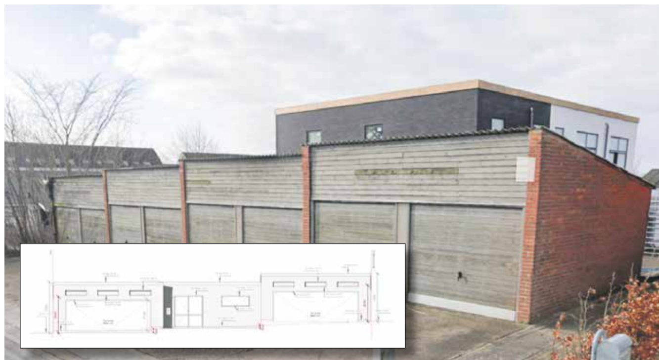
Her ses det oprindelige garageanlægget i Solbyen, der skal erstattes af nyt byggeri.
