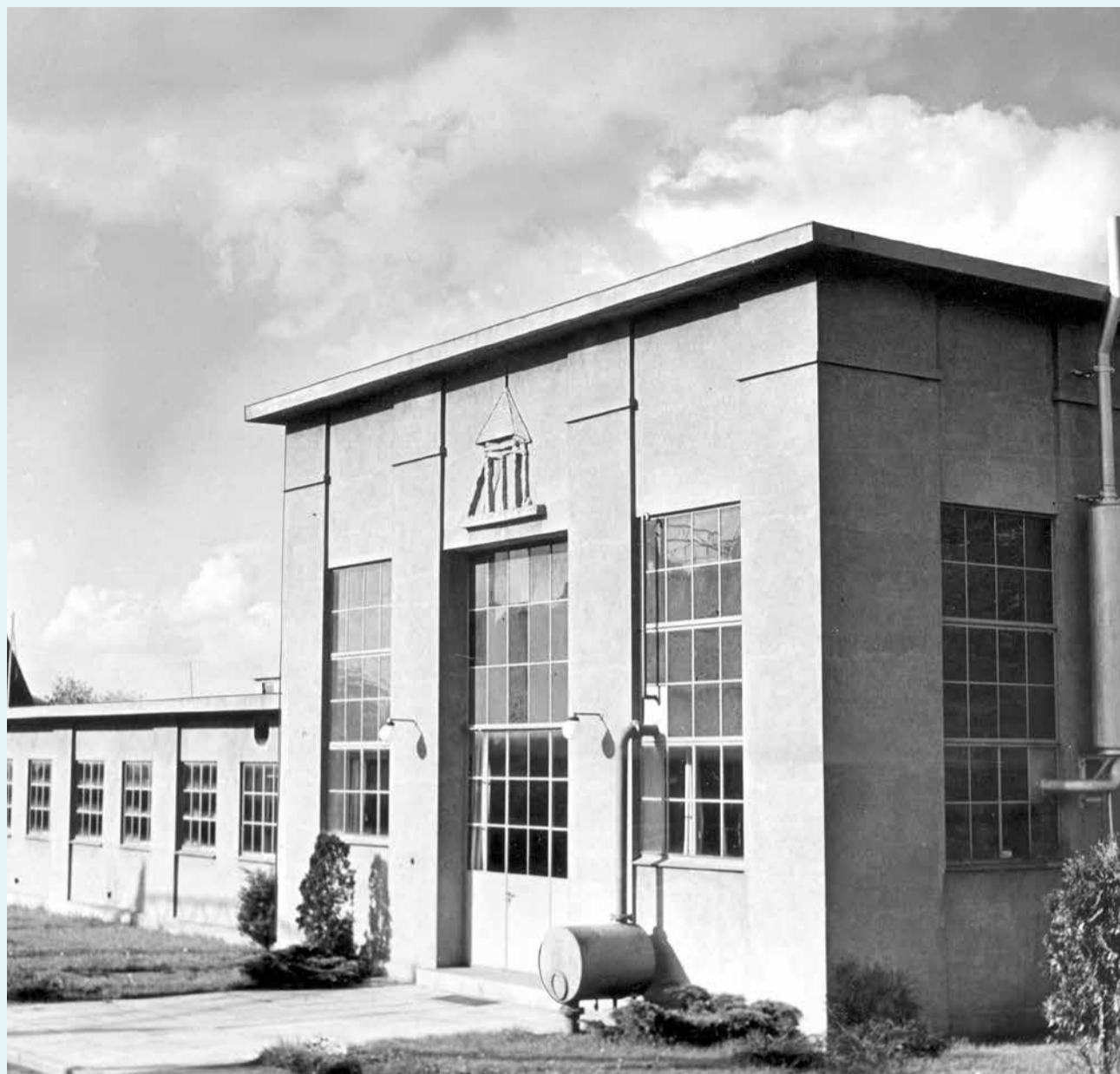
Hasseri Elværk på Poppelvej, opført 1936, senere overgået til Himmerlands Elforsyning. Det oprindelige elværk blev opført som privat værk i 1912 og overgik til kommunen 1919. I 1925 blev det for lille, og villabyen tilsluttedes Aalborgs elnet indtil 1936. Fotograf ukendt, foto i Aalborg Stadsarkiv.
