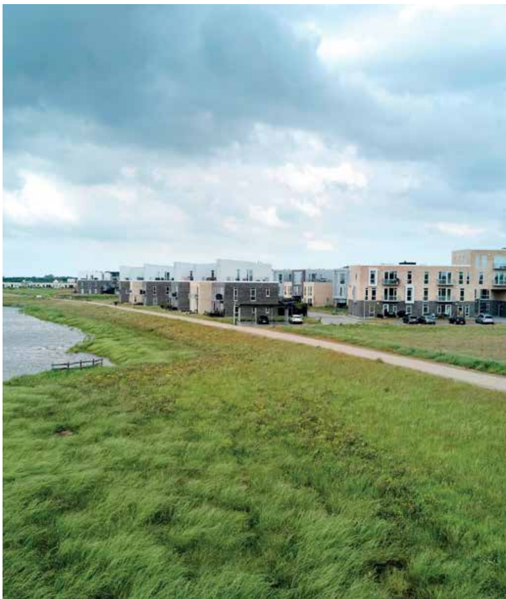
Himmerland Boligforening vil bygge 50 almene boliger på Sofiendal Enge.
