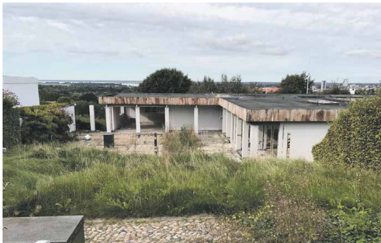
Hasserishøj 8, hvor ombygningen er i fuld gang. Foto Jens Skovgaard
